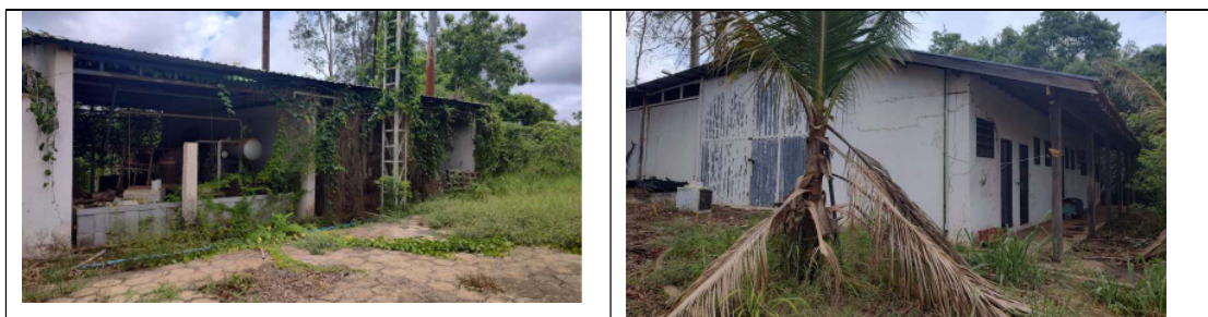
FOTO 3: instalações desativadas do laticínio
