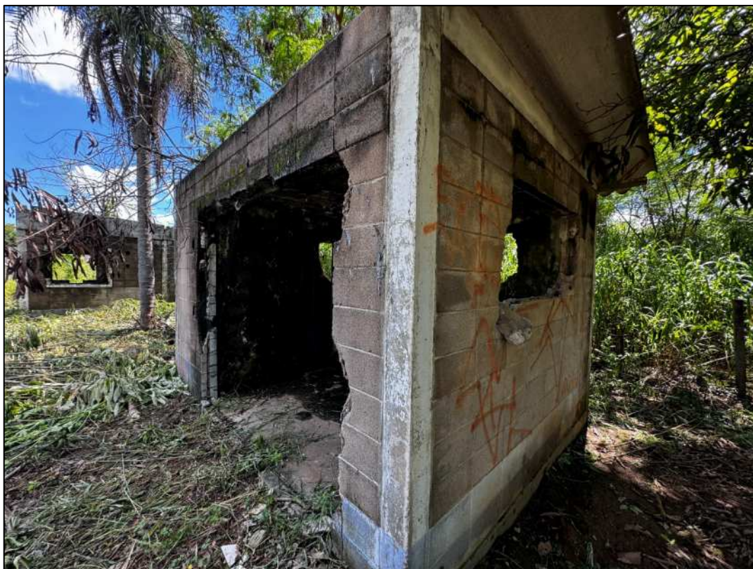
Foto 10 – Vista lateral direita da benfeitoria 1.
