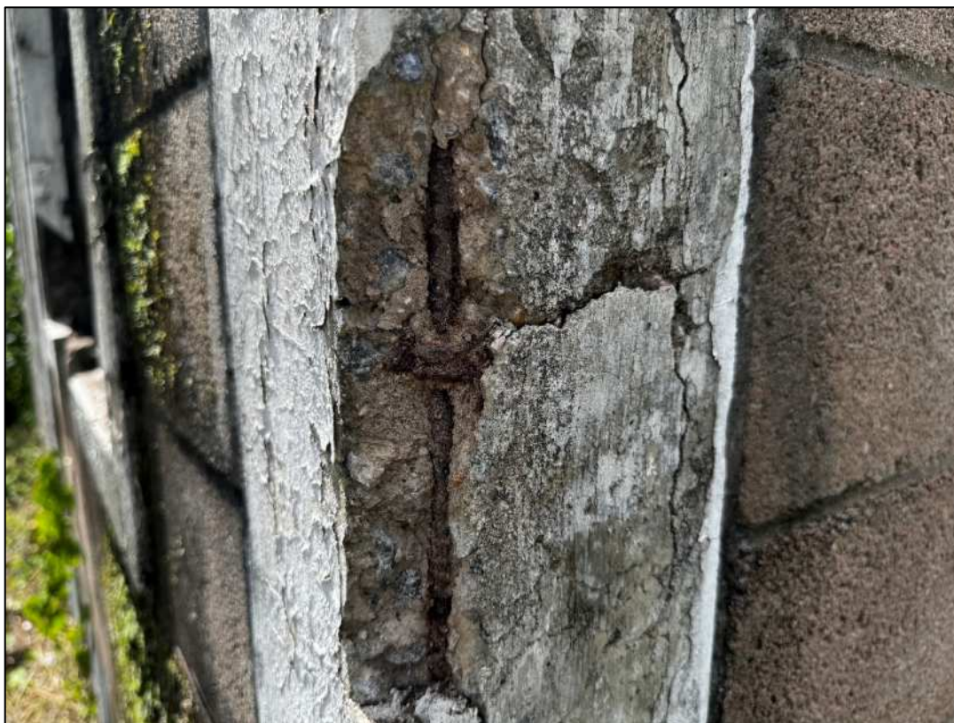
Foto 22 – Vista de parte da estrutura com corrosão do aço e avaria que necessita de recuperação.
