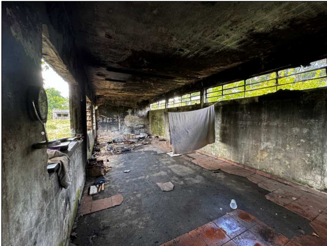
Foto 48 – Vista interna da benfeitoria.
