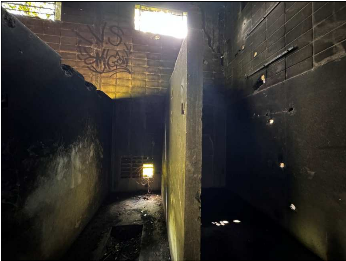
Foto 30 – Vista interna da benfeitoria.
