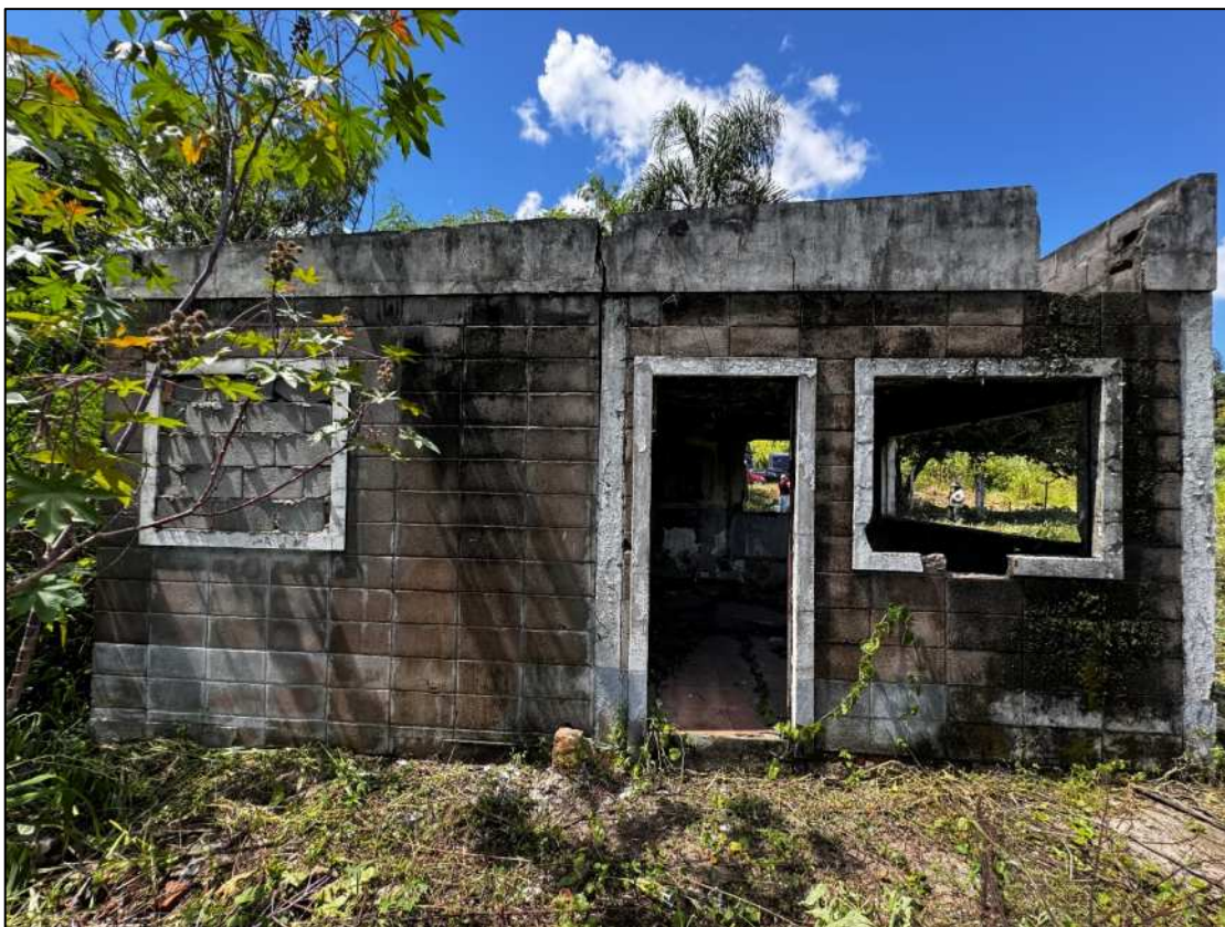
Foto 14 – Vista da lateral esquerda da benfeitoria 2.
