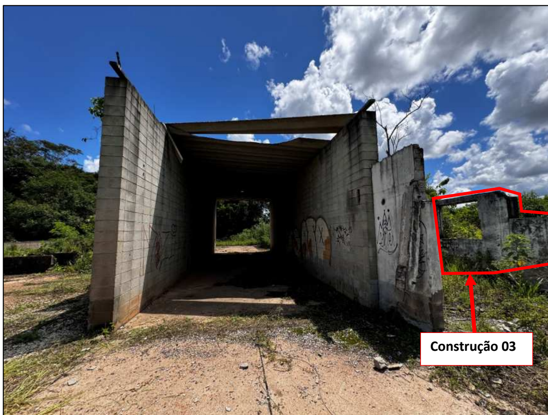
Foto 23 – Indicação da construção 3.
