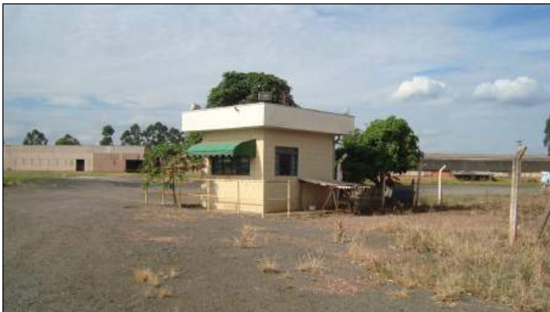
FOTO N.º 17:- Vista da guarita, onde ilustramos suas características construtivas.
