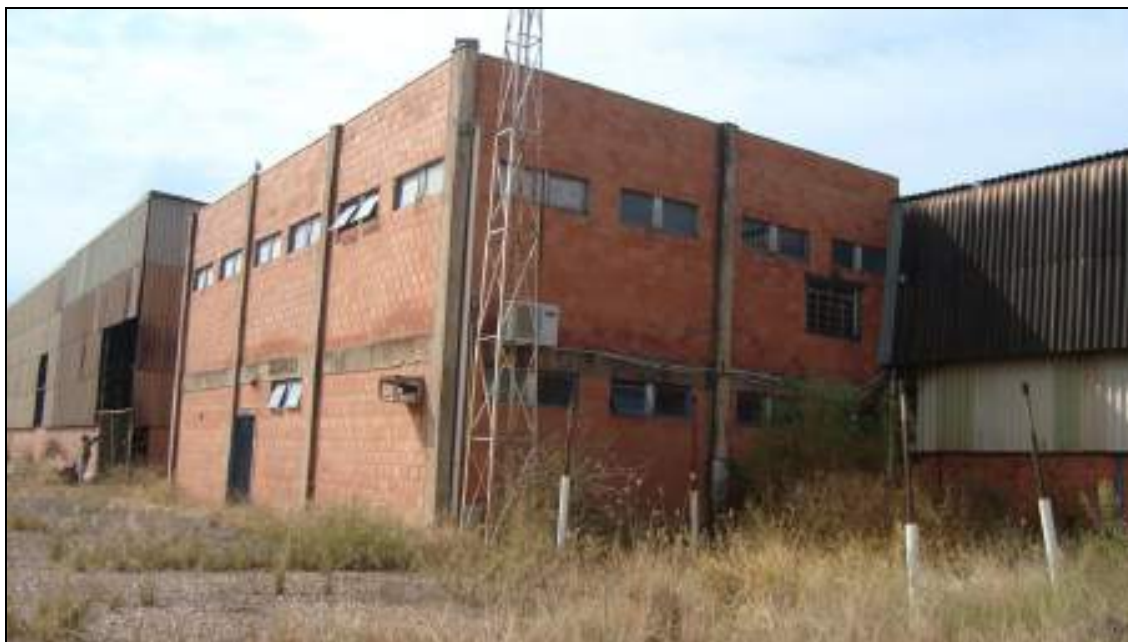
FOTO N.º 02:- Vista do prédio do escritório, construído em alvenaria de tijolos a vista, esquadras de ferro.
