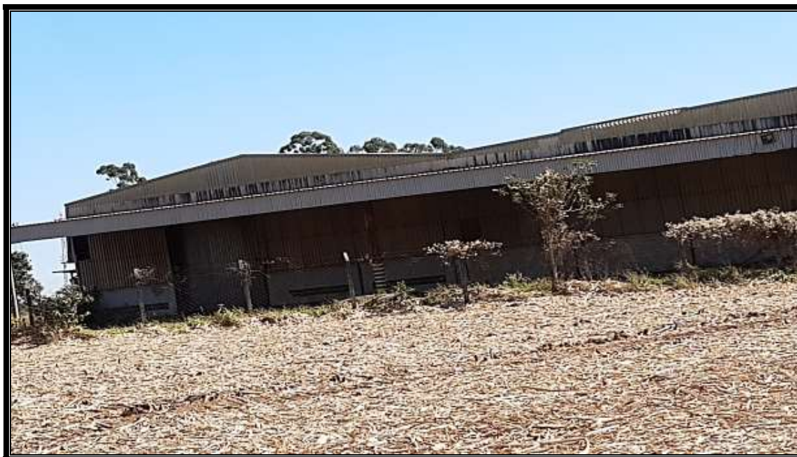
FOTO N.º 05:- Vista da cobertura situada na frente do prédio da produção, em estrutura metálica.
