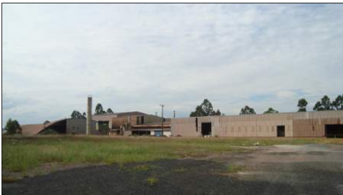
FOTO N.º 18:- Vista geral do imóvel em avaliação, e das edificações existentes em seu interior.
