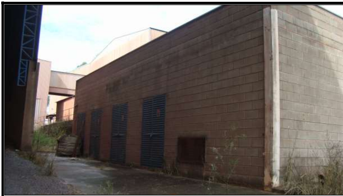
FOTO N.º 08:- Vista do prédio da cabina de energia elétrica, construída em blocos de concreto.
