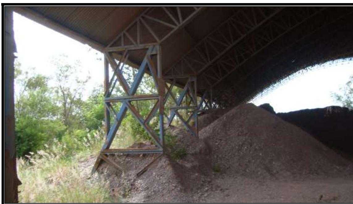
FOTO N.º 10:- Vista do galpão de secagem de argila, onde ilustramos as características da construção.
