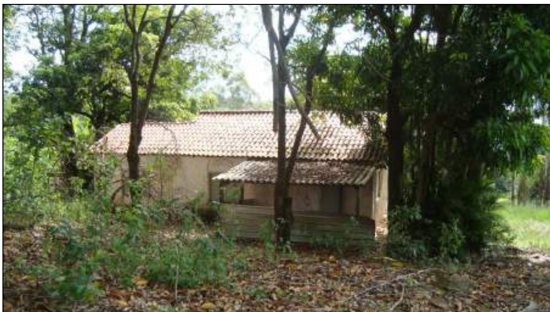
FOTO N.º 10:- Vista da casa residencial onde ilustramos suas características construtivas.
