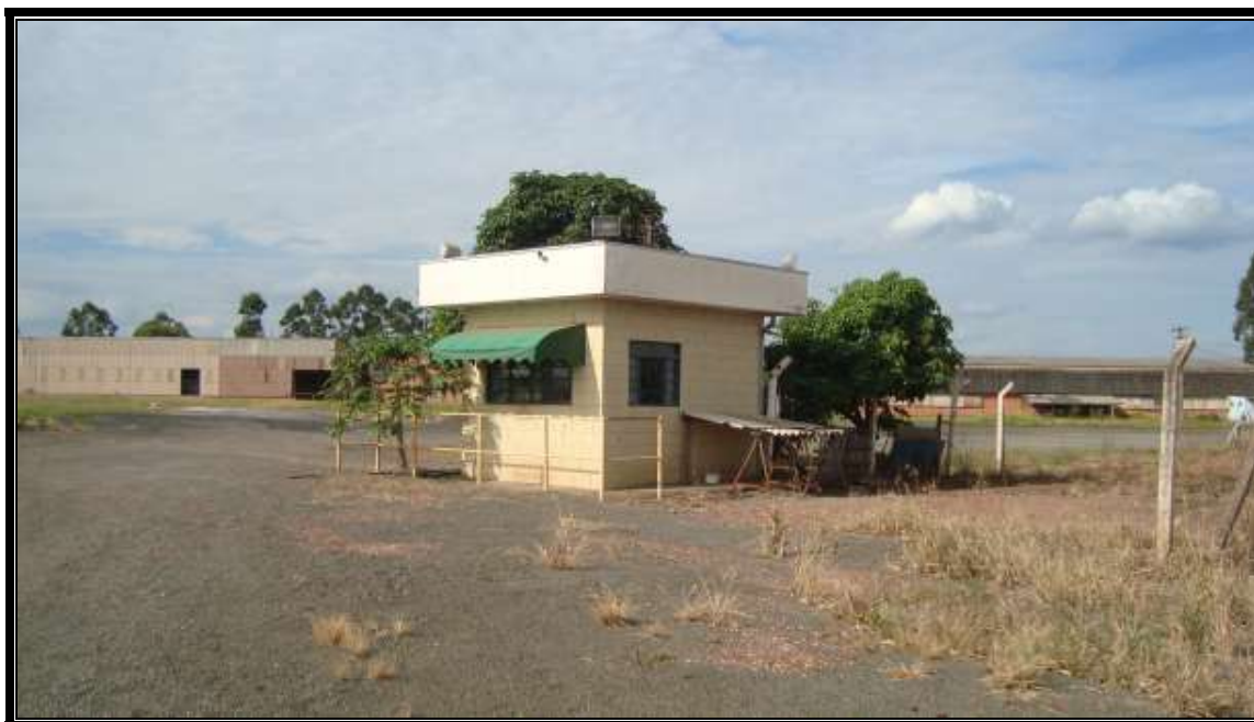
FOTO N.º 18:- Vista da guarita, onde ilustramos suas características construtivas.
