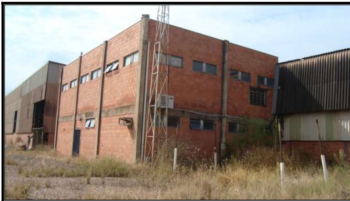
FOTO N.º 03:- Vista do prédio do escritório, construído em alvenaria de tijolos a vista, esquadras de ferro, com acabamento interno em piso cerâmico e tinta latex.
