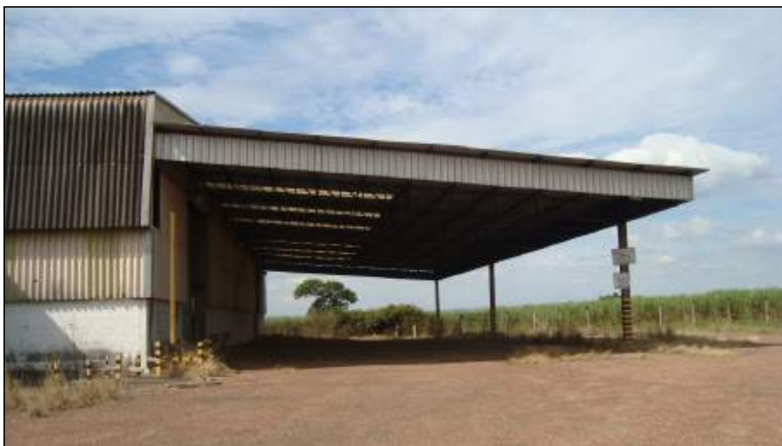
FOTO N.º 04:- Vista da cobertura da frente do prédio da produção, em estrutura metálica.
