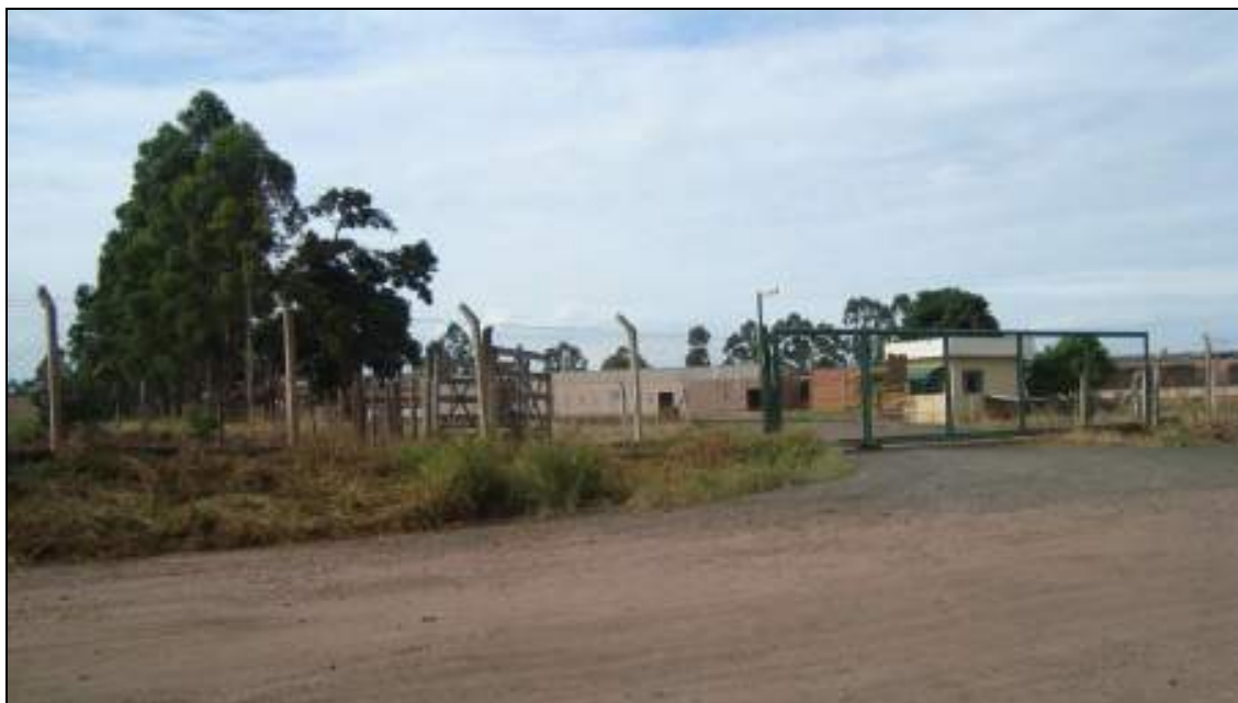
FOTO N.º 01:- Vista do imóvel denominado Sítio Santo Antonio, situada na Estrada Municipal Rio Claro – Brotas, distante 200,00 metros da Rodovia Washington Luiz - Corumbataí.
