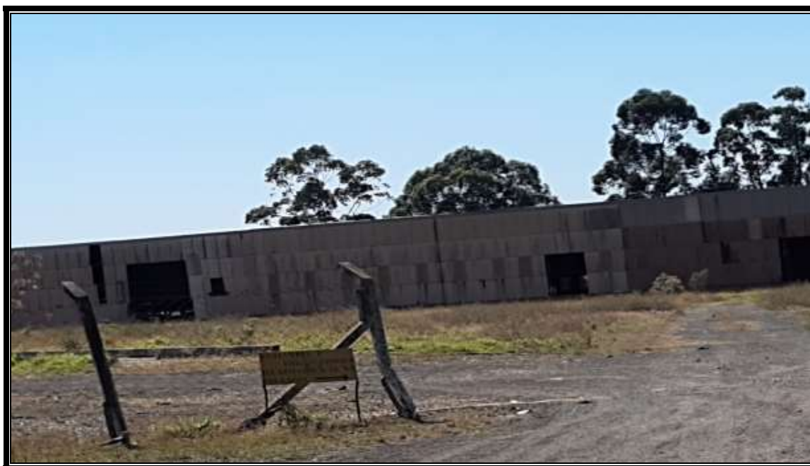
FOTO N.º 06:- Vista do prédio da produção, onde ilustramos seus acabamentos.
