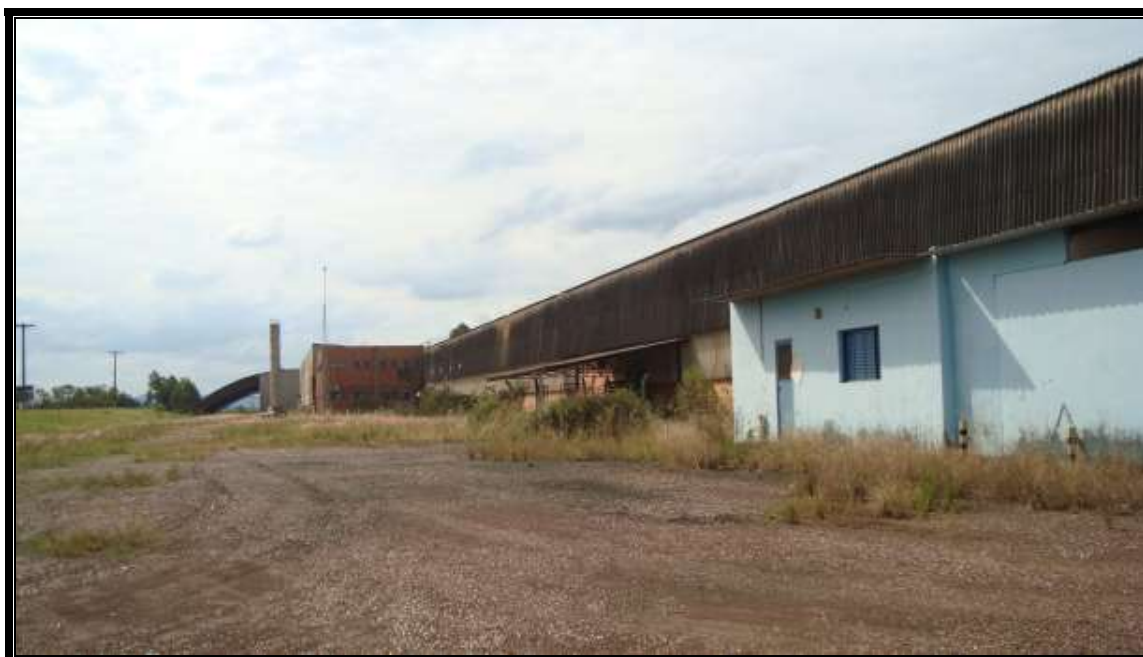
FOTO N.º 04:- Vista do prédio da produção, construído em alvenaria de e do depósito e banheiros construídos em alvenaria com acabamento em tinta látex.
