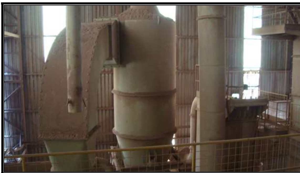
FOTO N.º 12:- Vista do interior do prédio da área de filtragem.
