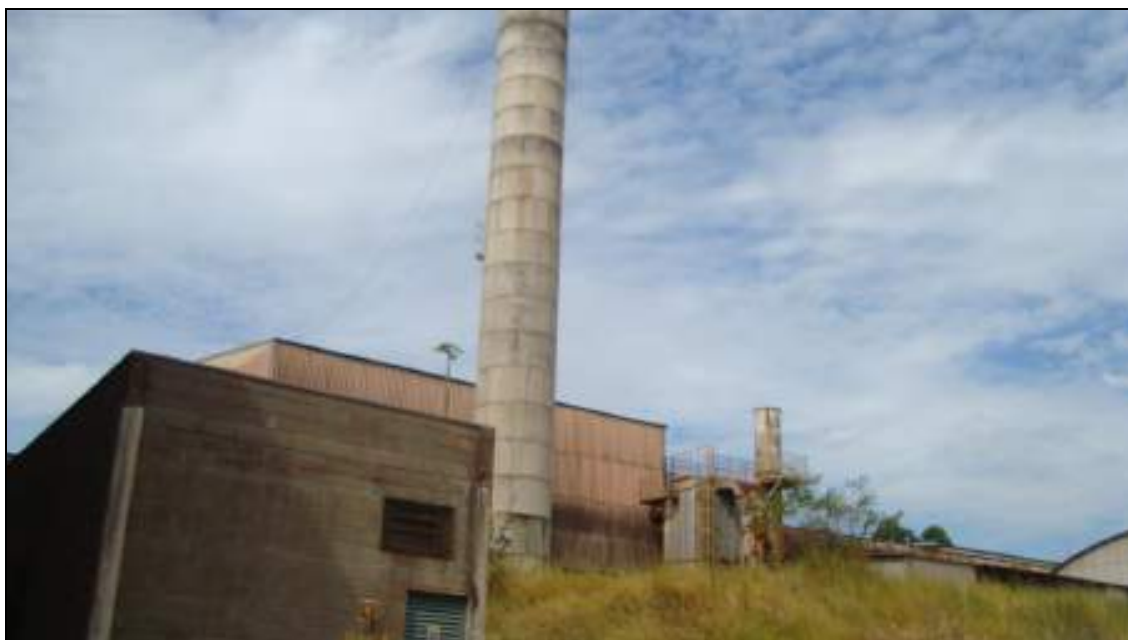
FOTO N.º 08:- Vista da caixa d'água construída em concreto.
