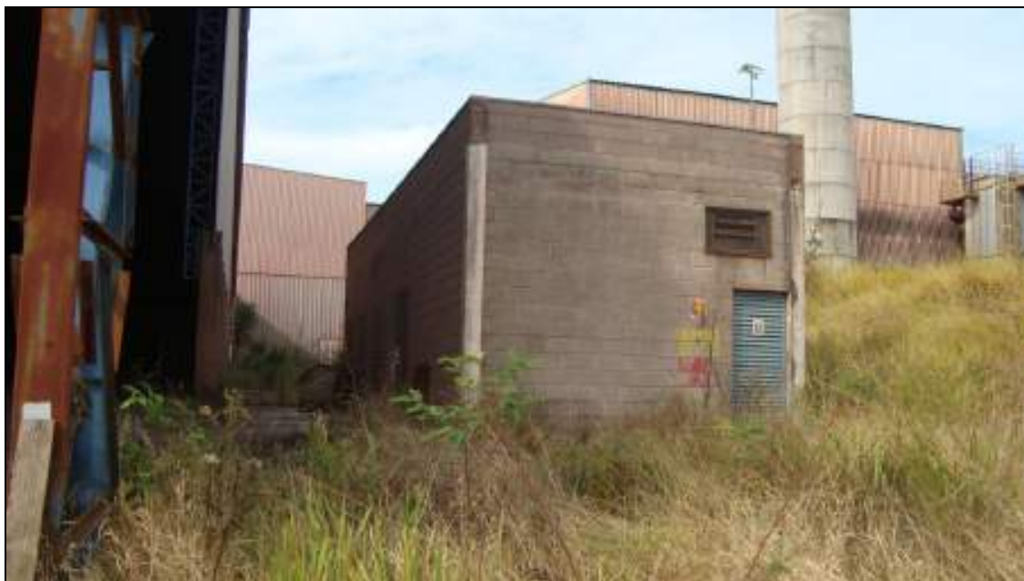
FOTO N.º 07:- Vista do prédio da cabina de energia elétrica, construída em blocos de concreto.
