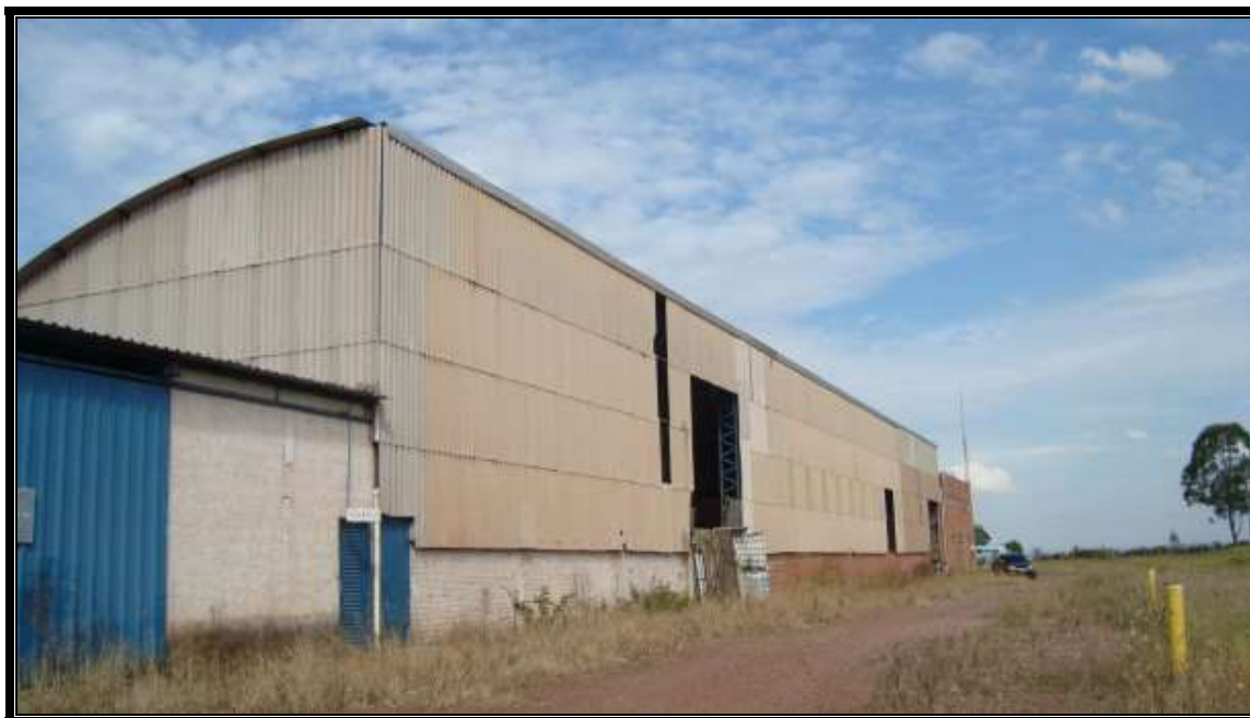
FOTO N.º 07:- Vista de outro ponto do prédio da produção, onde ilustramos seus acabamentos.
