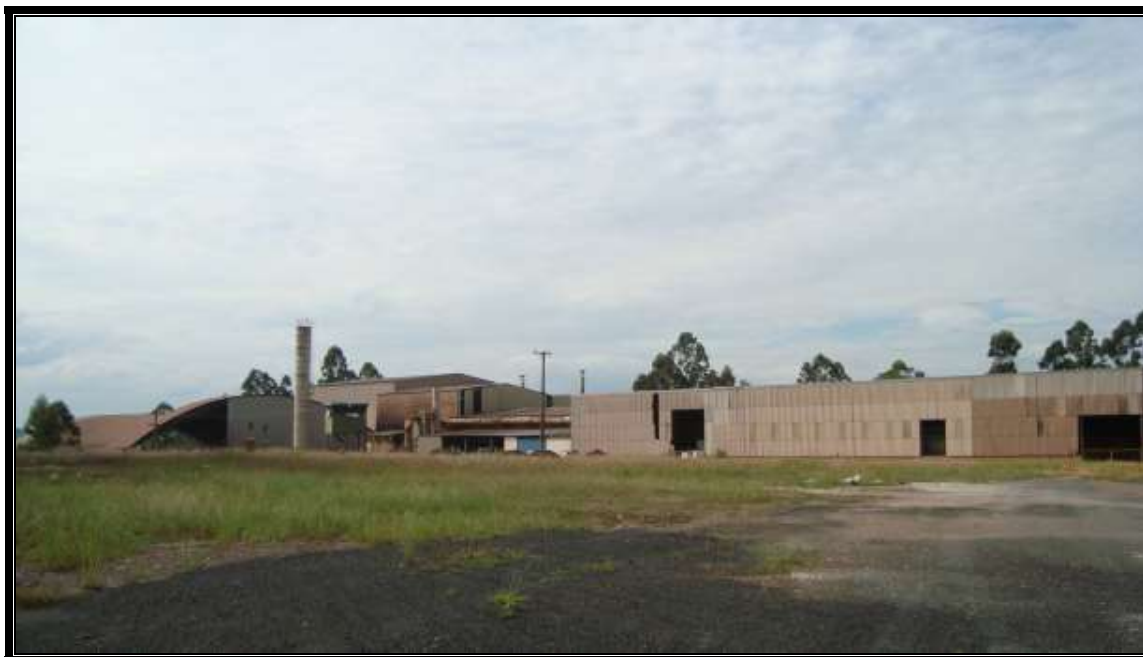
FOTO N.º 19:- Vista geral do imóvel em avaliação, e das edificações existentes em seu interior.
