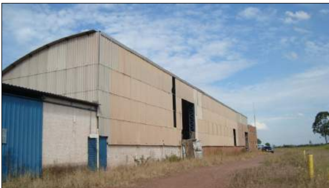
FOTO N.º 06:- Vista de outro ponto do prédio da produção, onde ilustramos seus acabamentos.
