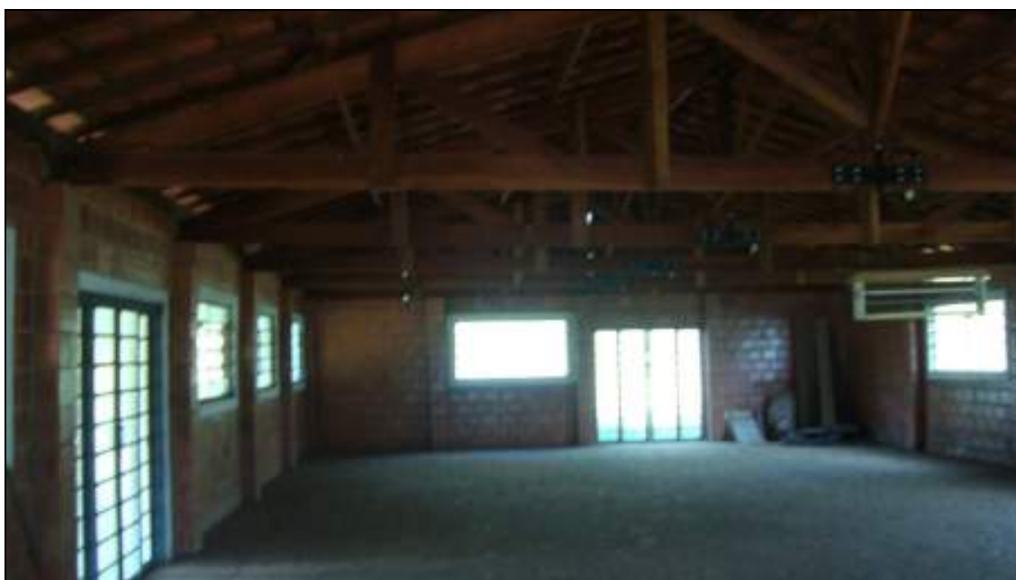
FOTO N.º 16:- Vista interna do salão de festas, onde ilustramos suas características construtivas.
