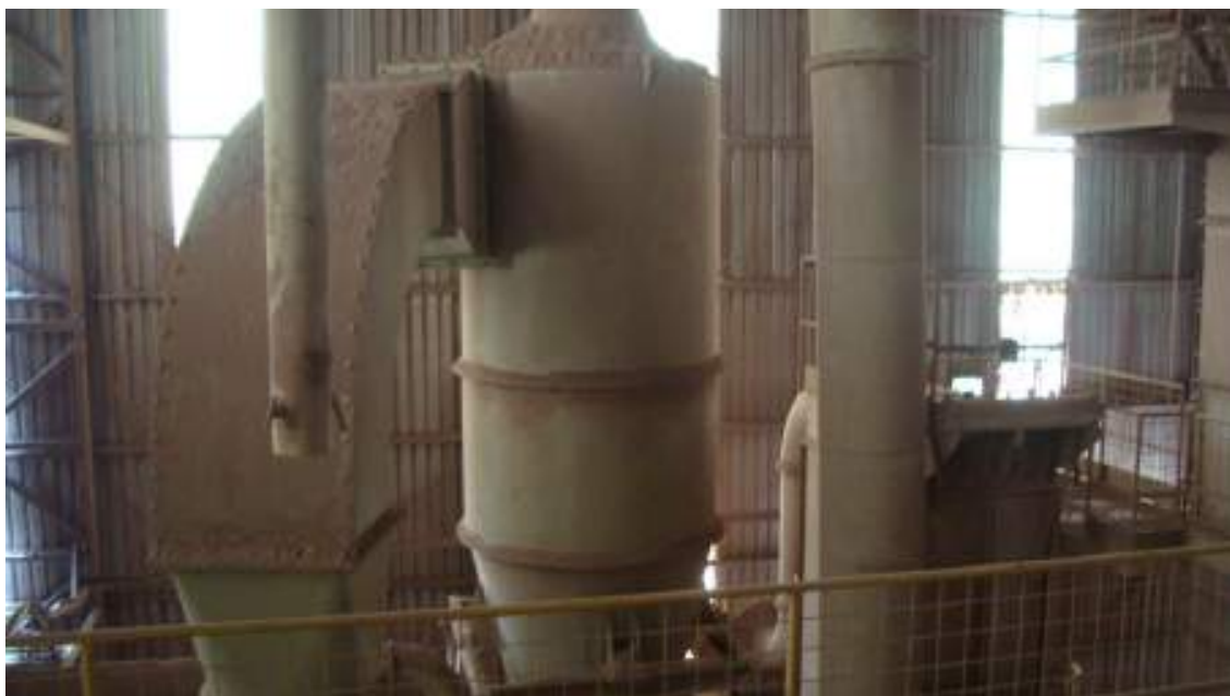
FOTO N.º 11:- Vista do interior do prédio da área de filtragem.
