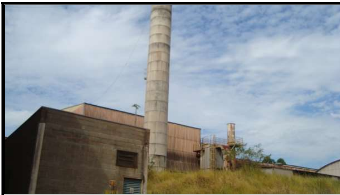
FOTO N.º 09:- Vista da caixa d'água construída em concreto.
