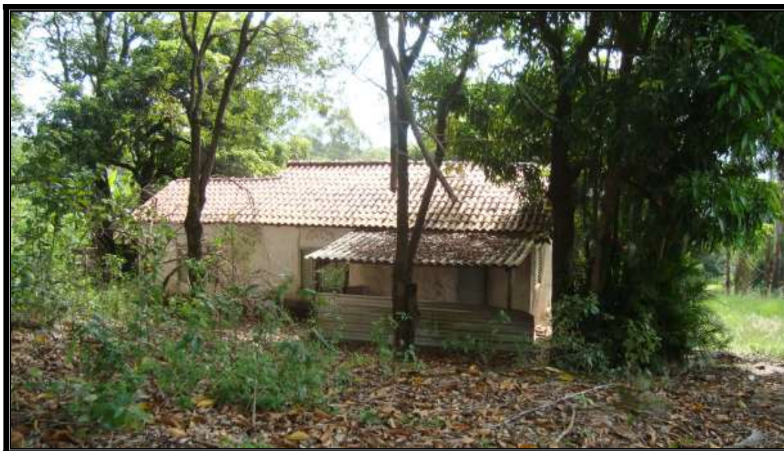
FOTO N.º 11:- Vista da casa residencial onde ilustramos suas características construtivas.
